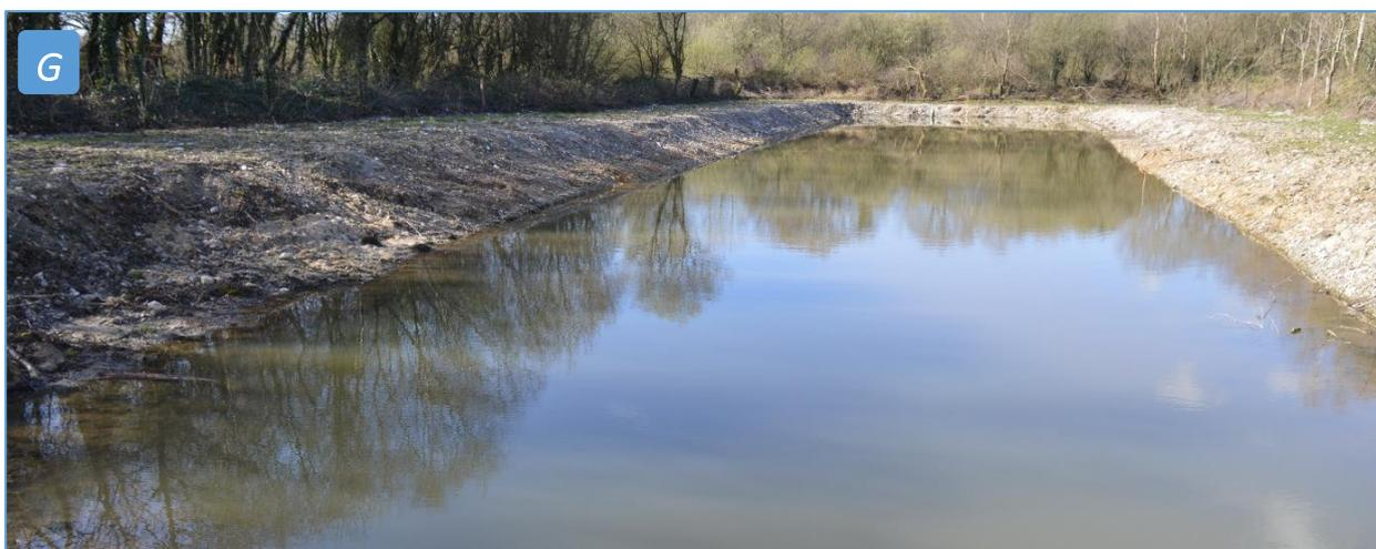
Fig. 44 : Bassin terminal de décantation
